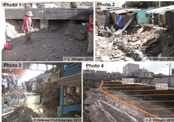
Figure 3 : Photos de terrain : (1) Ouverture de pont obstruée dans le quartier Mariano Bustamante ; (2) Bâtiments endommagés Av. Venezuela-J. Ibañez ; (3) Résidus de l'inondation Marché Palomar ; (4) Erosion de berge gauche en aval du Centre Commercial La Negrita.
