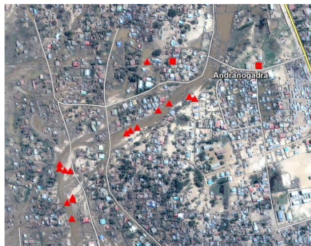
Figure 4 : Mise en eau d'un ancien cours d'eau au cœur de la ville de Toliara. Les triangles rouges correspondent à des bâtiments emportés par les flots, tels qu'observés par Pléiades
