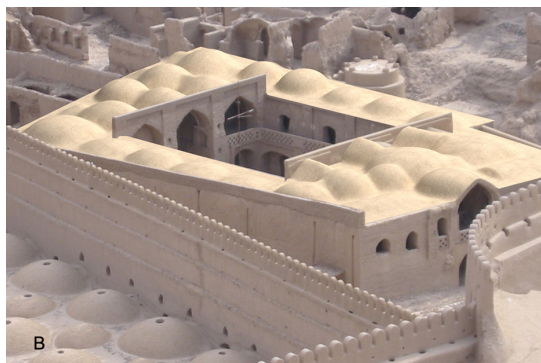
Figure 8 : (A) Position des points utilisés sur le modèle du toit pour la définition de la caméra utilisée pour la photographie de la figure 1A. (B) Modèle de la toiture après ajustements sur la photographie prise après restauration et avant tremblement de terre.
