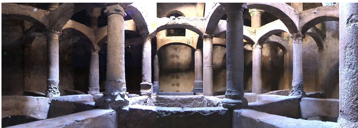
FIGURE 3 : Vue intérieure de la cuve de la citerne montrant les dispositifs mis en œuvre pour le géoréférencement des nuages de points (sphères et cibles). Cliché L. Borel ©CEAlex.
