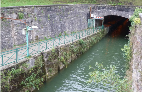
FIGURE 8: Vue générale d'une entrée du tunnel de Revin. Le canal est en contrebas d'une piste cyclable protégée par un garde-corps.
