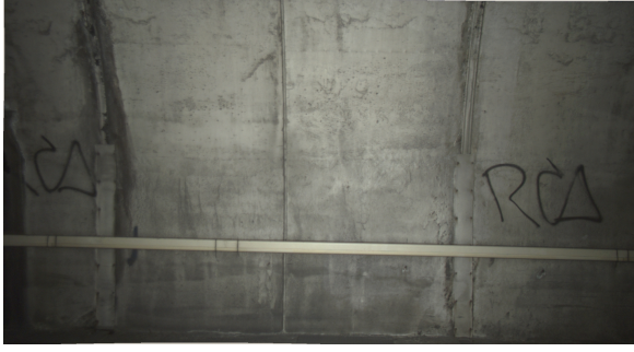
FIGURE 4: Exemples d'images de piédroit acquises en tunnel routier.
