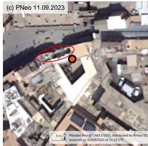
Figure 8 (a, b, c) : Illustration d'un bâtiment "Damaged" dans le secteur de Marrakech
